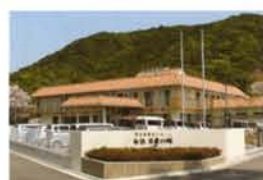
特別養護老人ホーム 白浜 日置の家 〒649-2511 和歌山県西牟婁郡白浜町日置2037 TEL 0739-87-2222 平成19年4月 開設
